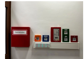
Feuerwehrpläne, Feuerwehrbedienteil & Druckknopfmelder
